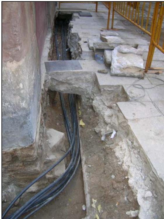
Foto 10: Col·locació nova línia elèctrica de baixa tensió.
