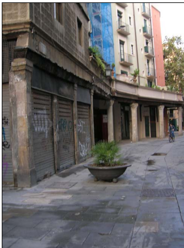
Foto 8: Porxos de la finca Rec 44 on es porta la nova línia elèctrica catalogats com a BCIL.
